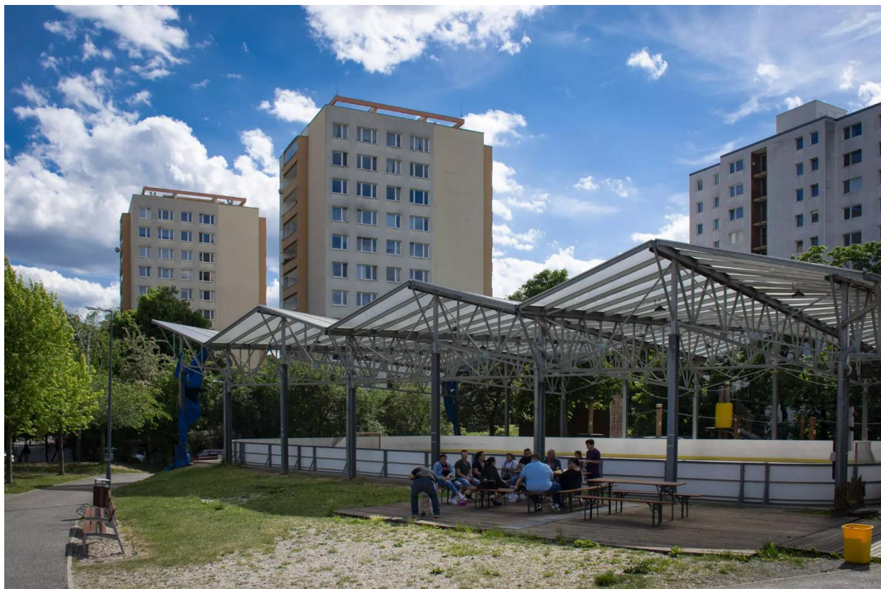
Obrázek č. 2 - zastřešení kluziště se svítidly (původní stav)
